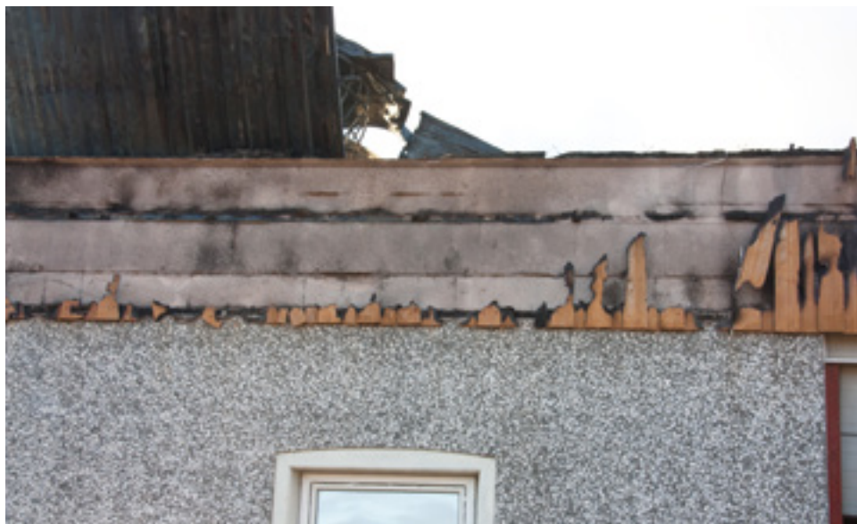
Brannskillene mellom husdyrrommet og resten av bygningen holdt stand under brannen.
